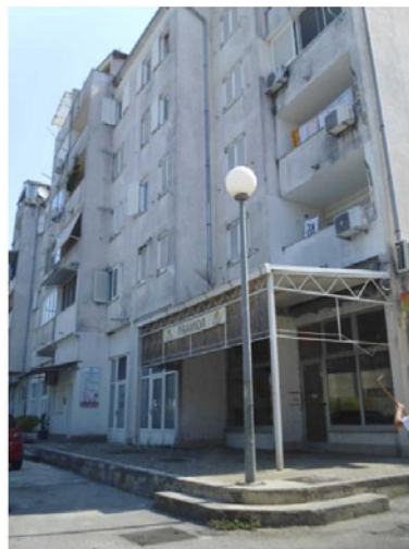
2.3.6. Čelični stup JR-4
