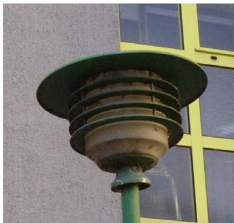
Slika 2.4.12. Zamućen difuzor svjetiljke
