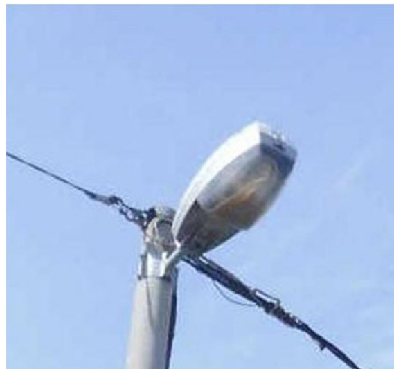
Slika 2.4.11. Prljavština u difuzoru svjetiljke
