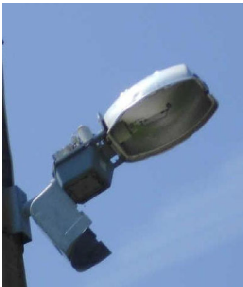
Slika 2.4.8. Oštećena svjetiljka
