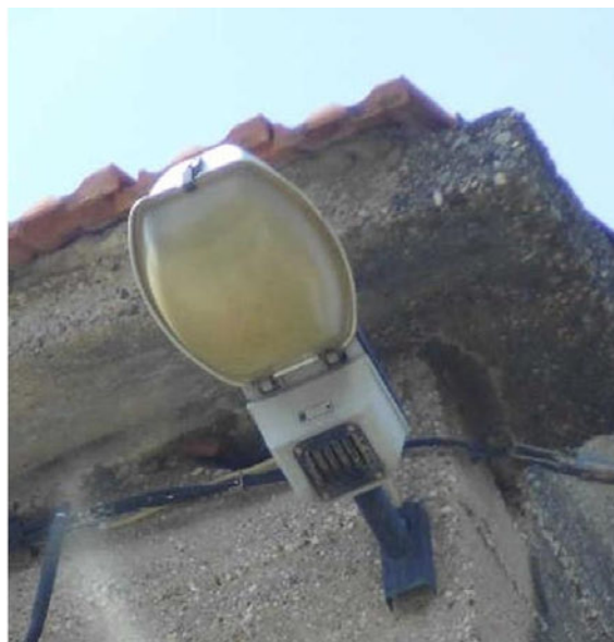
Slika 2.4.9. Zamućen difuzor svjetiljke
