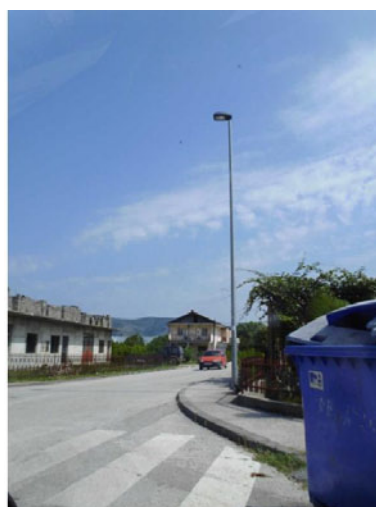
2.3.4. Čelični stup JR-3
