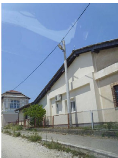
2.3.3. Betonski stup JR
