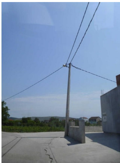
2.3.13. Primjer stupa izvan vertikalnog položaja
